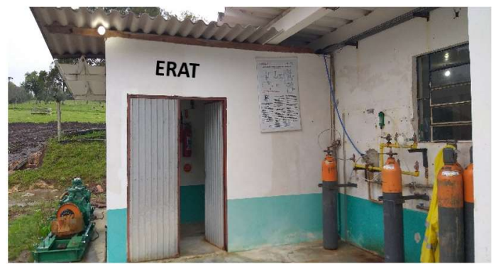
Figura 55: Vista Externa da ERAT
