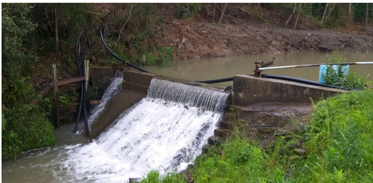
Figura 6: Vista geral da barragem de nível do rio São Lourenço
