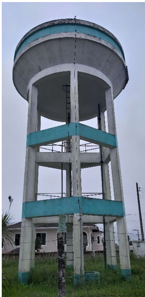
Figura 62: Reservatório R3 - vista geral
