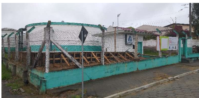
Figura 56: Reservatório R1 - Visão Geral
