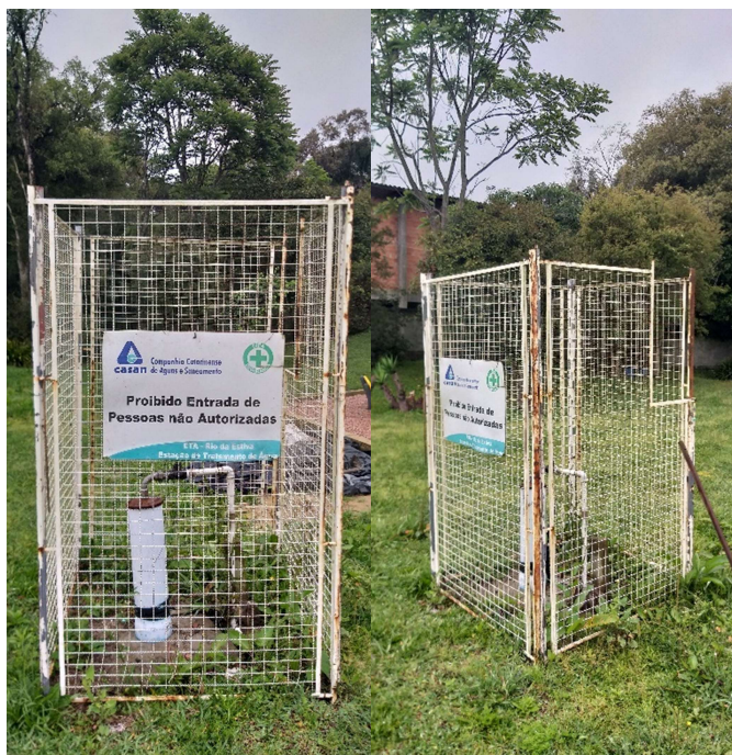
Figura 115: Poço SAA Rio da Estiva - vista geral
