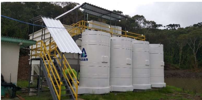
Figura 20: Estruturas de acesso aos módulo
