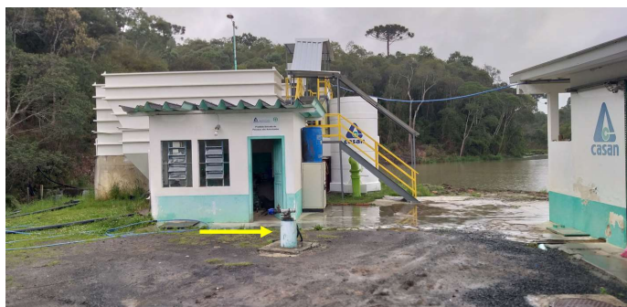
Figura 90: Poço ETA - localização em relação à ETA
