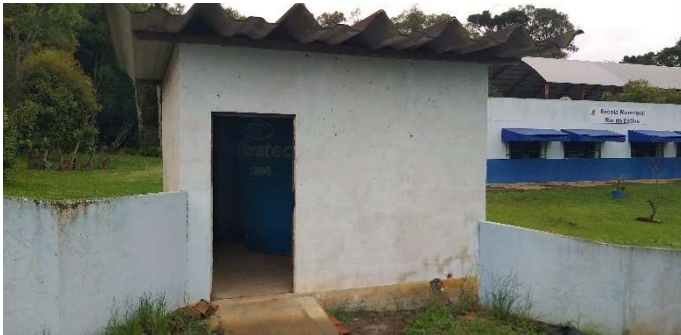
Figura 117: Poço SAA Rio da Estiva - casa de química
