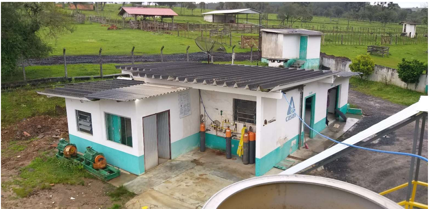
Figura 17: Vista geral da ETA
