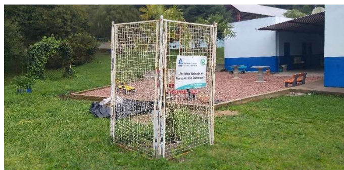
Figura 114: Poço SAA Rio da Estiva - vista geral
