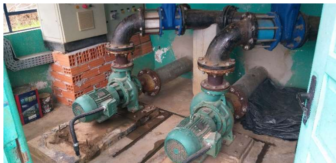
Figura 15: Conjuntos motobombas
