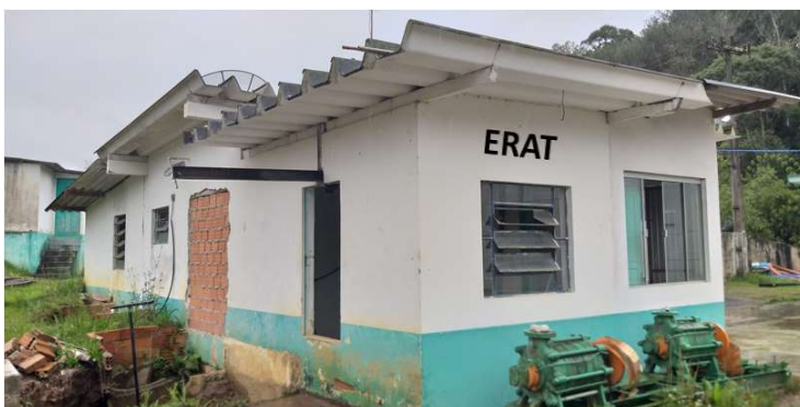
Figura 54: Vista Externa da ERAT
