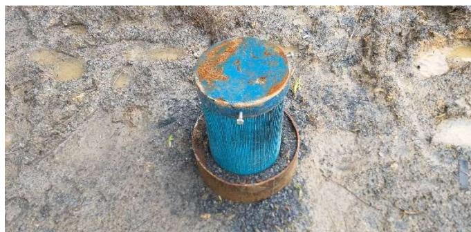
Figura 89: Poço Bairro Vila Nova
