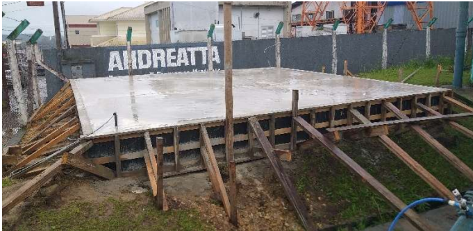
Figura 58: Reservatório R1 - radier para o novo reservatório de 200 m 3
