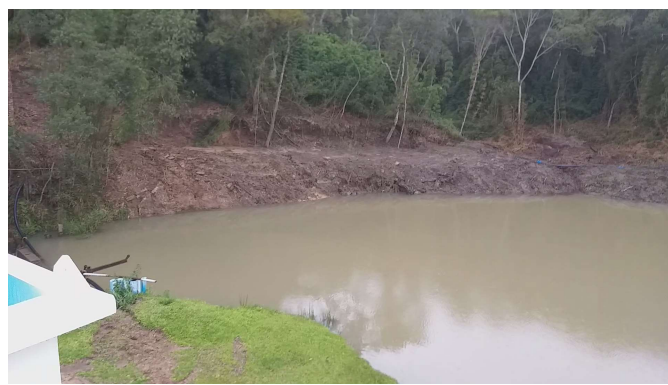
Figura 10: Lago de acumulação de água bruta
