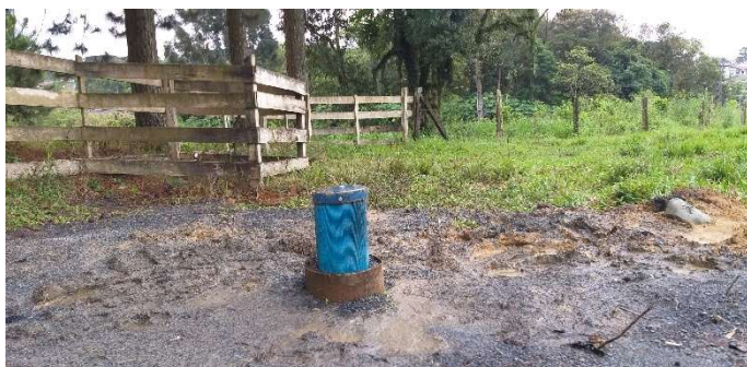
Figura 88: Poço Bairro Vila Nova
