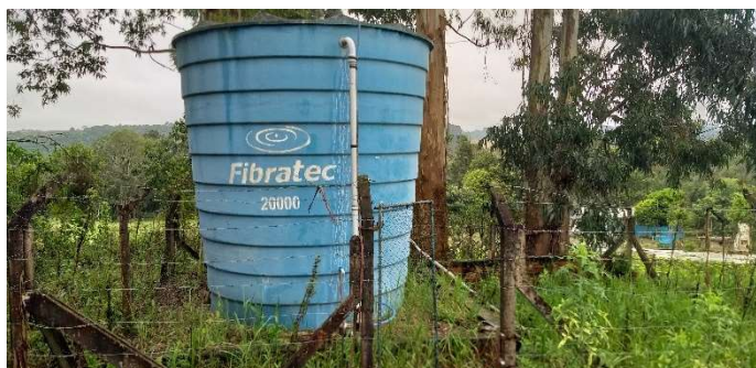
Figura 124: SAA Rio da Estiva - Reservatório
