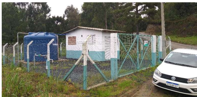
Figura 98: Poço Moema: visão geral das instalações
