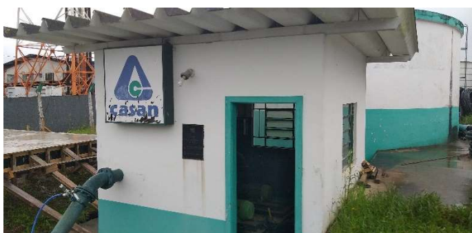
Figura 74: ERAT do Reservatório R1 - visão geral
