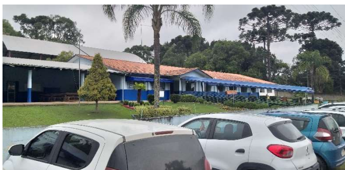
Figura 113: Vista Geral - Escola Municipal Rio da Estiva
