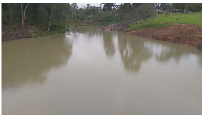
Figura 9: Lago de acumulação de água bruta
