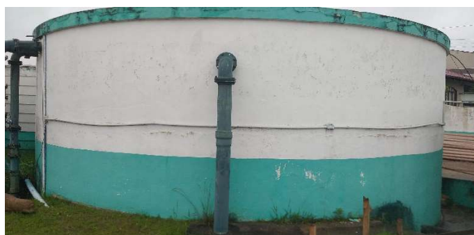
Figura 57: Reservatório Apoiado em concreto estrutural
