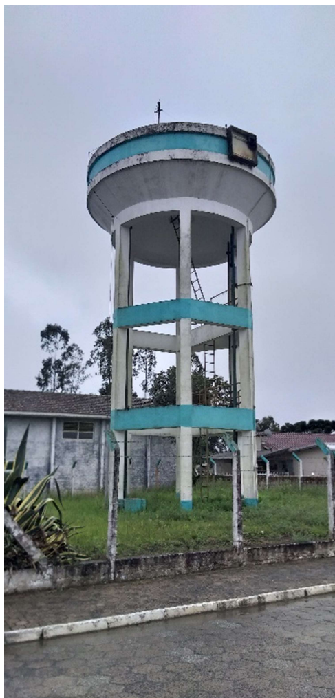
Figura 63: Reservatório R3 - vista geral
