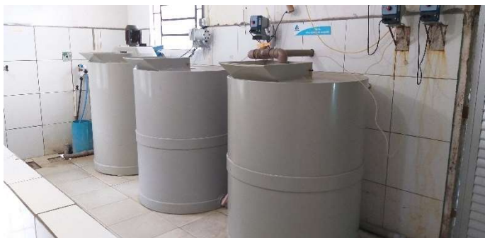
Figura 40: Tanques de agitação/mistura de barrilha, policloreto de alumínio (PAC), flúor e barrilha
