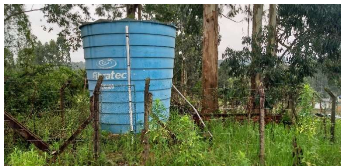
Figura 125: SAA Rio da Estiva - Reservatório
