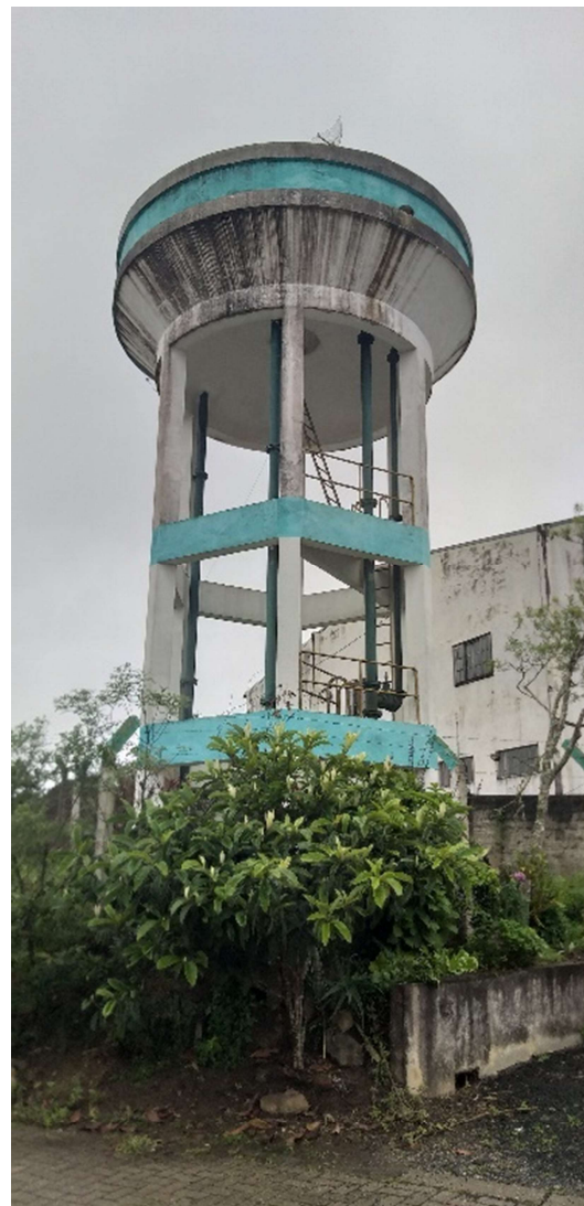
Figura 61: Reservatório R2 - Vista Geral
