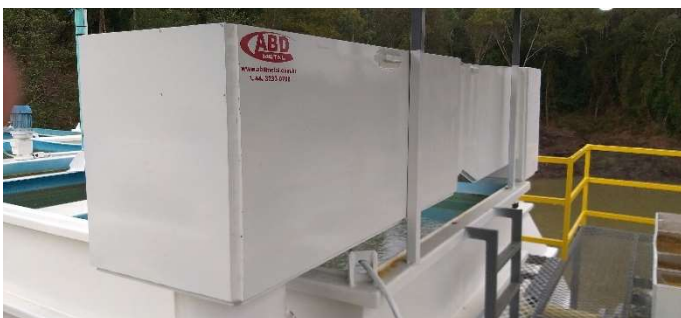
Figura 22: Calha Parshall
