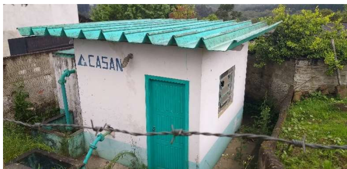
Figura 78: ERAT do Reservatório R2 - visão geral
