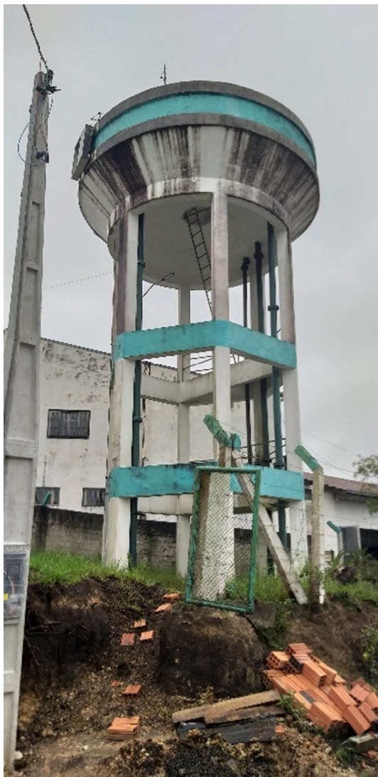
Figura 60: Reservatório R2 - Novas instalações do Poste Padrão Celesc e local onde será instalado o novo booster
