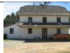
Cobertura com telhas francesa e fibro cimento
