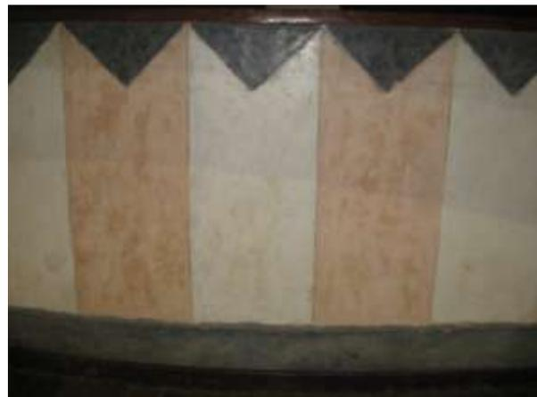
Figura 17 Detalhe do acabamento, provavelmente em pó de mármore, da moldura do palco
