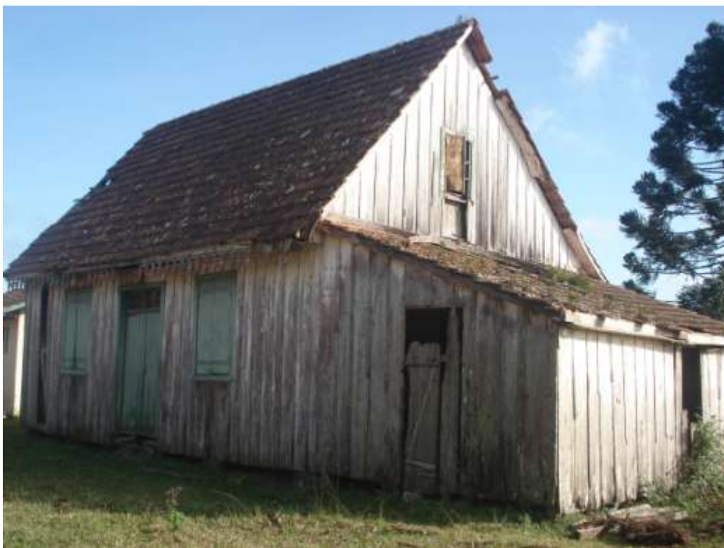
Figura 17 - Fachada frontal Escola da Moeminha.
