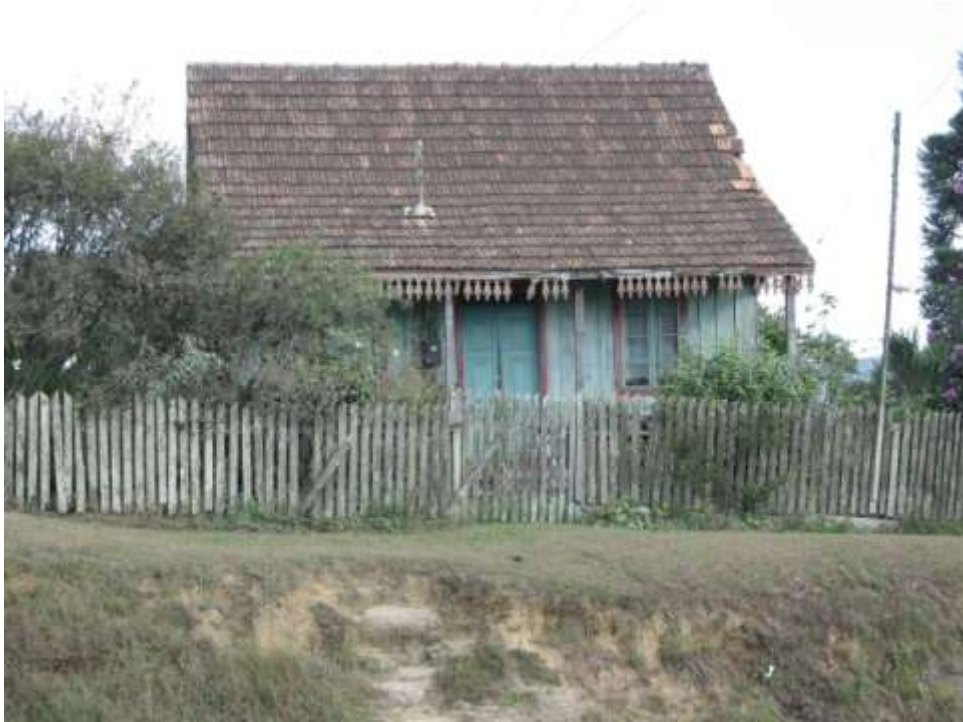
Figura 11 - Vista frontal da Casa Jankoski
