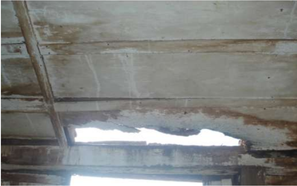
Figura 18 - Detalhe do forro do anexo Escola Moeminha.
