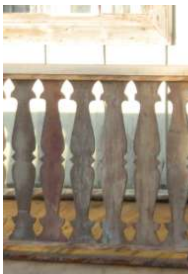
Figura 7 - Detalhe do guarda corpo - Casa Buba
