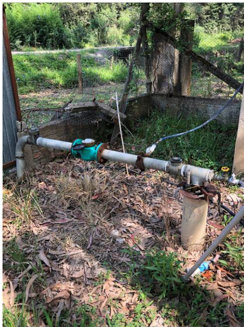
Figura 30: Poço Rio Vermelho
