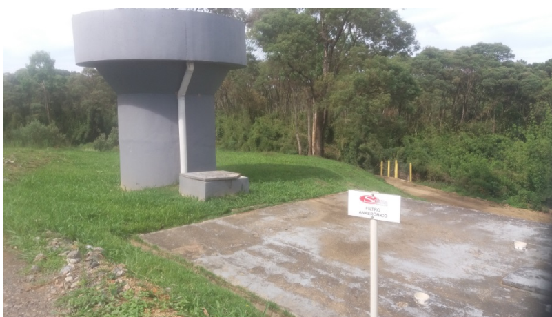
Figura 98: Reator Anaeróbio RALF.
