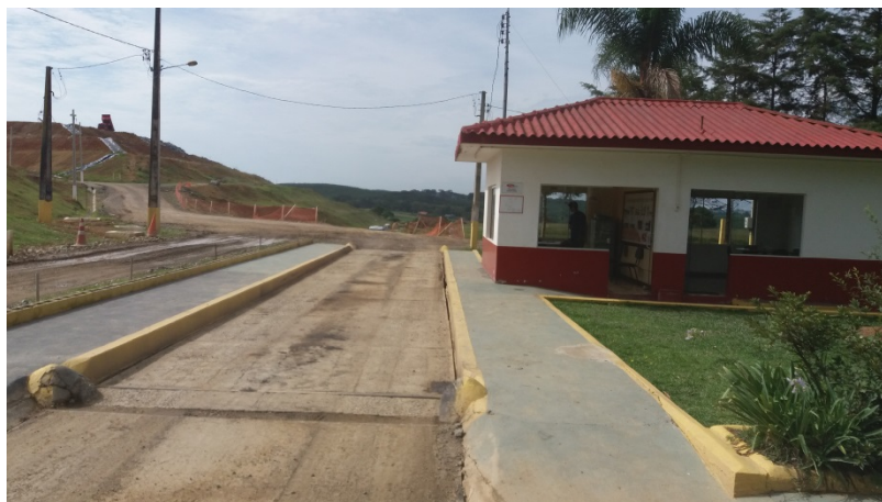
Figura 94: Balança de Pesagem do Aterro Sanitário.
