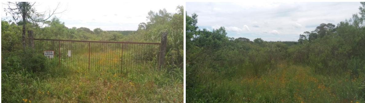
Figura 119: Crescimento de vegetação sobre área que recebeu resíduos sólidos.
