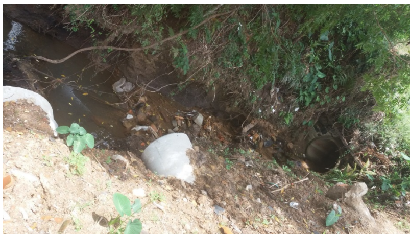
Figura 79: Ligações de esgoto no sistema de drenagem.
