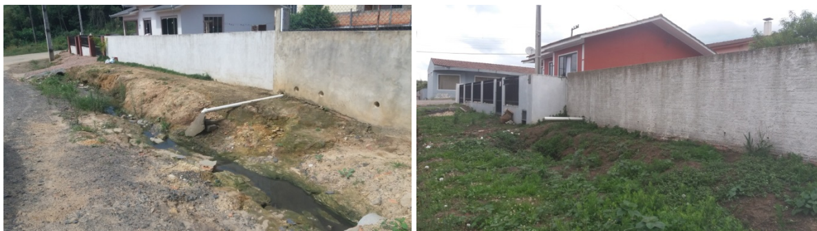
Figura 75: Contribuições de águas residuárias no sistema de drenagem natural. Rua José Kazmierczak- Bom Jesus. Fonte: Arquivo técnico da Consultoria, 2019.
