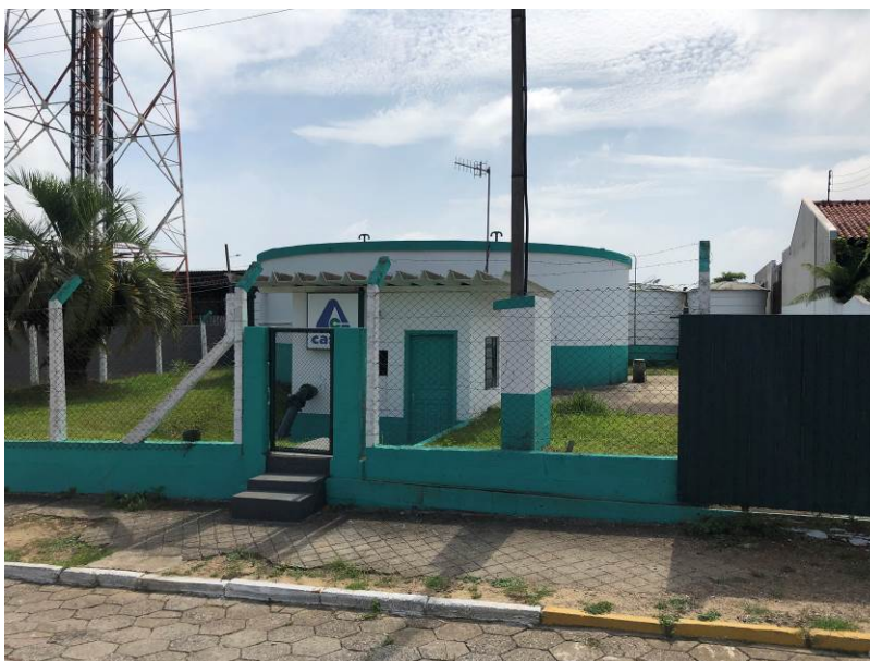
Figura 41: Reservatório Central – R1 Fonte: Arquivo técnico da consultoria, 2019.
