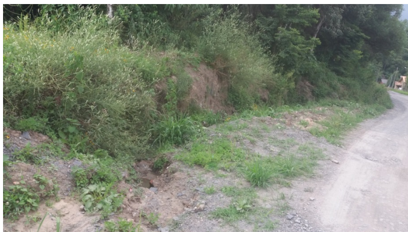
Figura 71: Rua não pavimentada e sem dispositivos de drenagem urbana.
