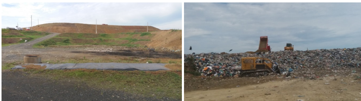
Figura 95: Resíduos Depositados na Frente de Trabalho.
