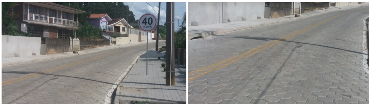
Figura 74: Obras de pavimentação com drenagem.
