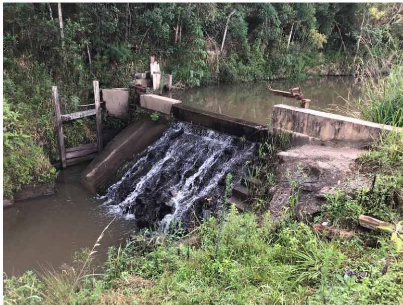
Figura 23: Vista da Captação no Rio São Lourenço
