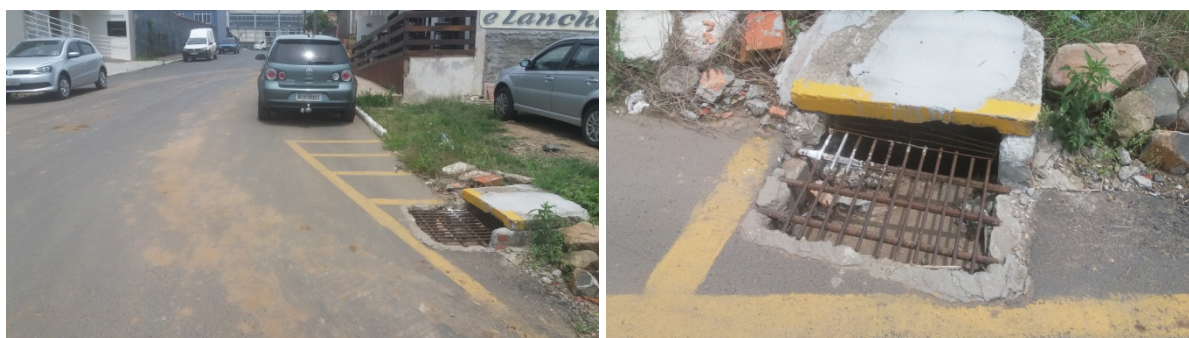
Figura 72: Exemplo de rua pavimentada com sistema de microdrenagem implantado.
