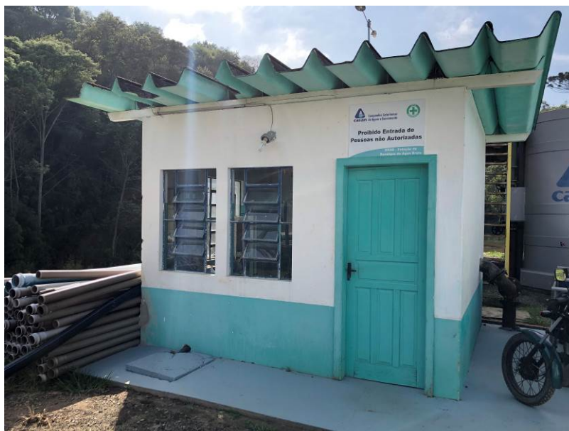
Figura 25: Estação de Recalque de Água Bruta – ERAB Fonte: Arquivo técnico da consultoria, 2019.
