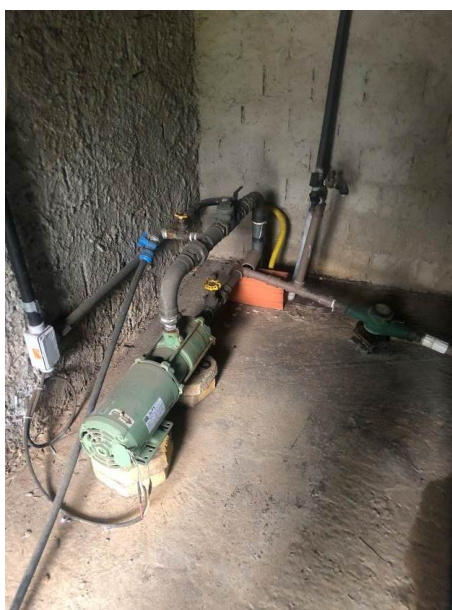
Figura 59: Recalque da Água Tratada
