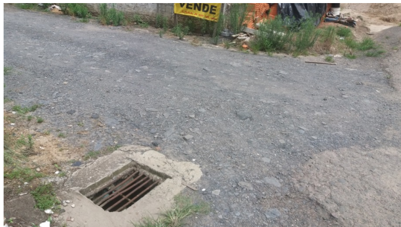
Figura 70: Exemplo de rua sem pavimentação, mas com sistema de microdrenagem implantado. Fonte: Arquivo técnico da Consultoria, 2019.
