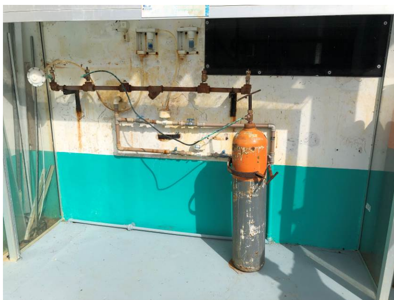
Figura 36: Desinfecção com Cloro Gasoso
