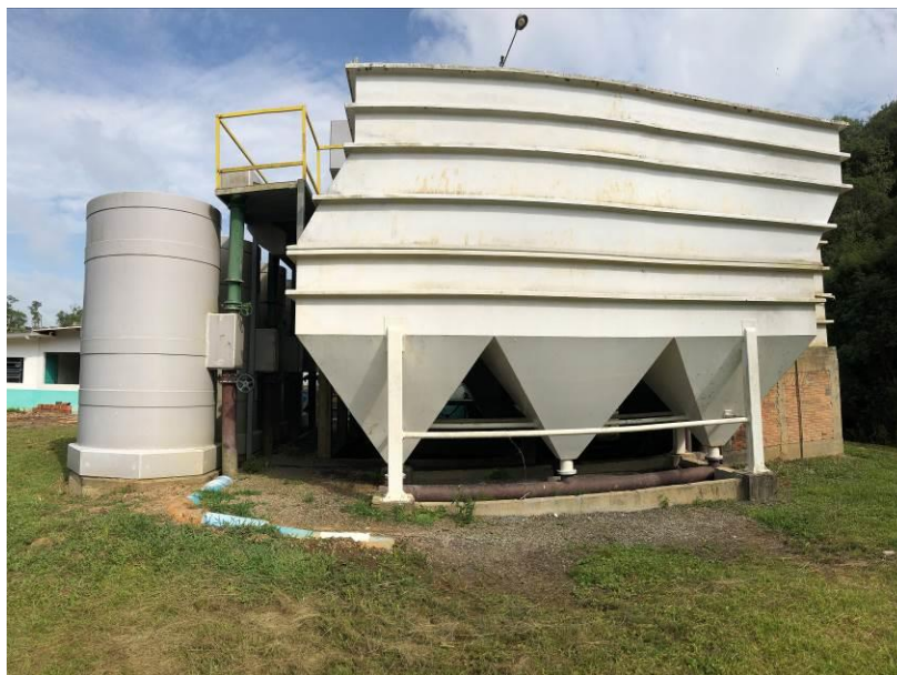
Figura 11: Vista Geral da ETA
