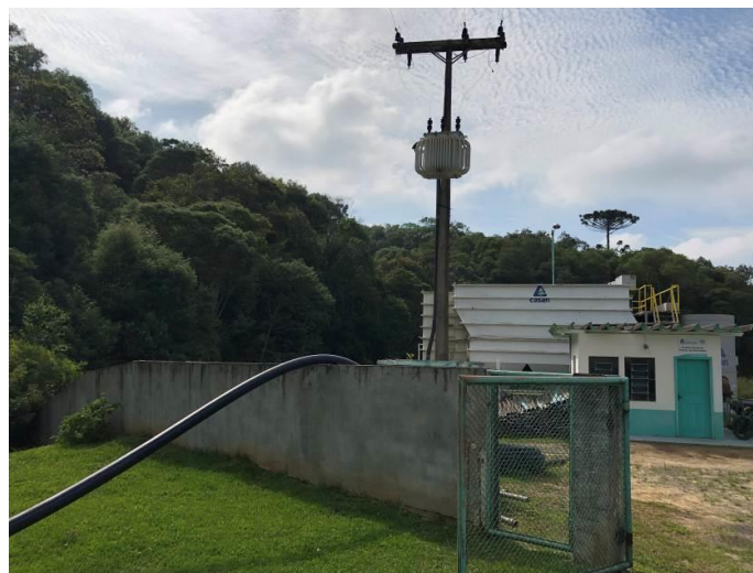
Figura 8: Adutora da Captação de Reforço
