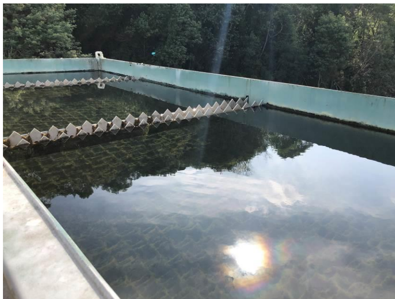
Figura 13: Decantador
