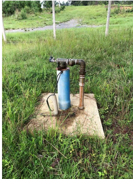
Figura 33: Poço de Captação
