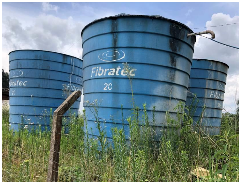
Figura 35: Centro de Reservação do SAA Moema Fonte: Arquivo técnico da consultoria, 2019.
