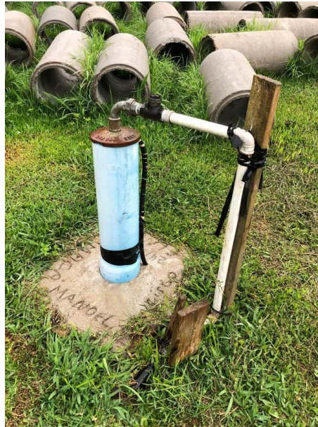
Figura 36: Poço de Captação
