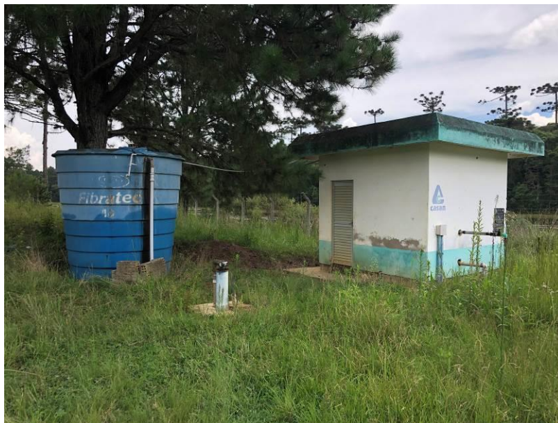
Figura 32: Vista Geral do Poço, Casa de Química e Tanque de Contato Fonte: Arquivo técnico da consultoria, 2019.
