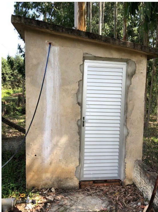
Figura 10: Casa de Química do Poço Rio Vermelho Fonte: Arquivo técnico da consultoria, 2019.
