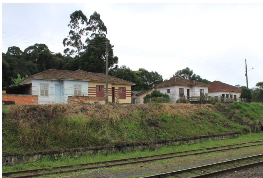
FIGURA 106: CASAS DOS FERROVIÁRIOS
