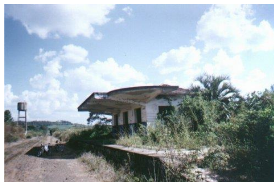
FIGURA 103: ESTAÇÃO FERROVIÁRIA CAPITÃO ADIL
