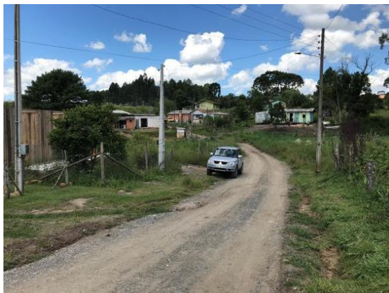
FIGURA 29: ÁREA DE RISCO NA RUA PRESIDENTE COSTA E SILVA – SETOR 3
