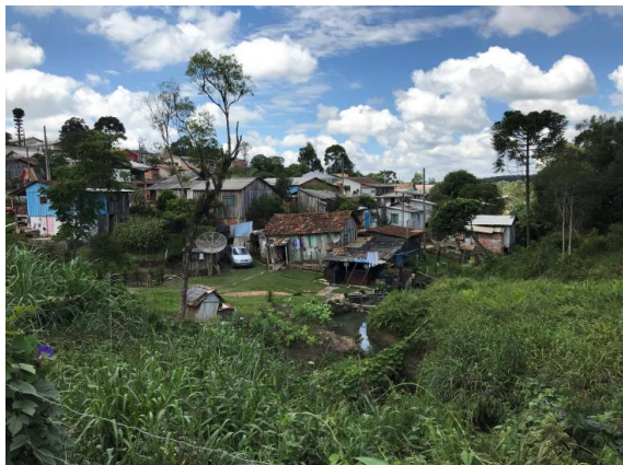
FIGURA 27: ÁREA DE RISCO NA RUA PAULO HENRIQUE VILESK - SETOR 1
