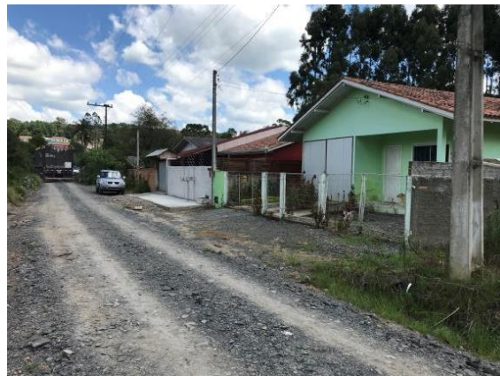
FIGURA 28: ÁREA DE RISCO NA RUA FRANCISCO DAVET – SETOR 2
