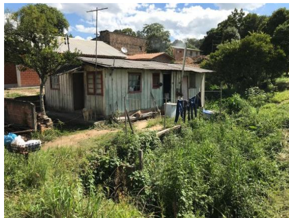
FIGURA 30: ÁREA DE RISCO NA RUA DUQUE DE CAXIAS – SETOR 4
