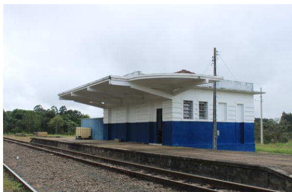
FIGURA 102: ESTAÇÃO FERROVIÁRIA ITAIÓPOLIS
