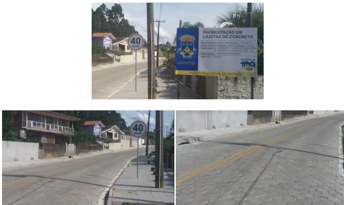
Figura 13: Obras de pavimentação com drenagem.
