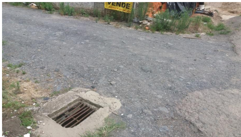
Figura 9: Exemplo de rua sem pavimentação, mas com sistema de microdrenagem implantado.
