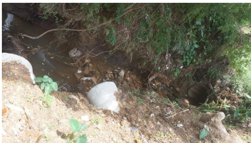
Figura 18: Ligações de esgoto no sistema de drenagem.
