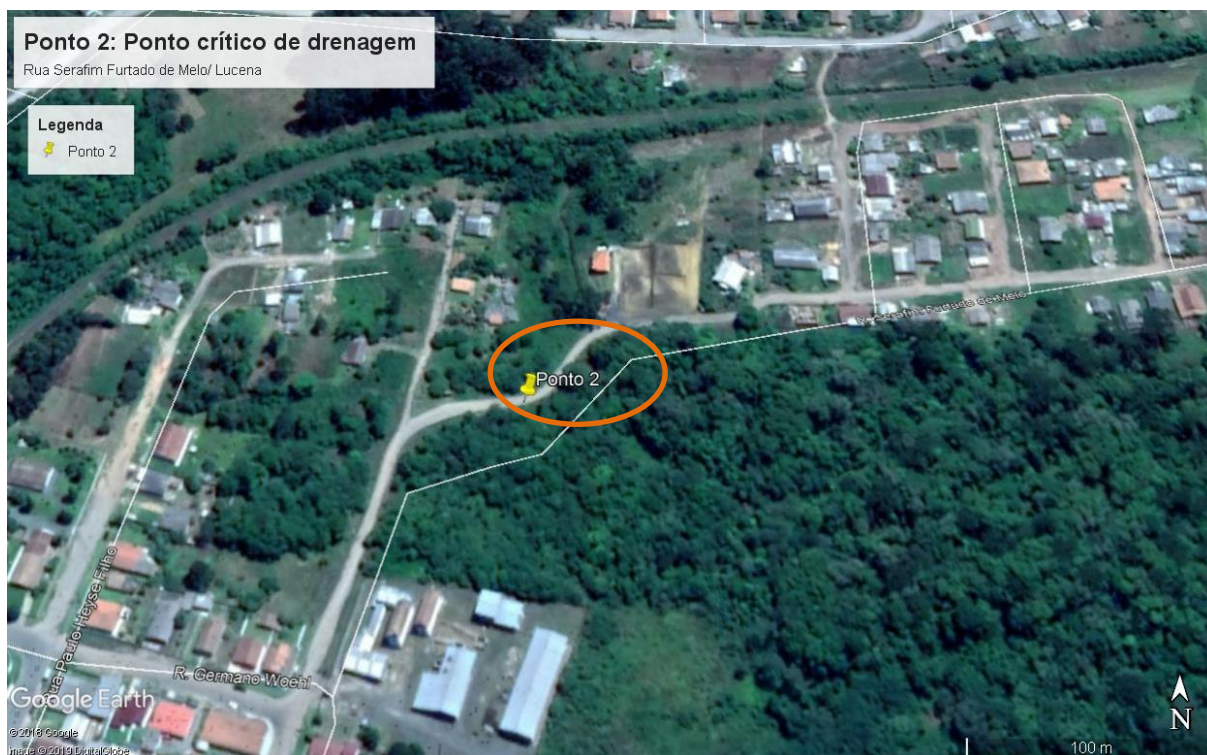
Figura 19: Ponto crítico de drenagem- deficiência no sistema. Ponto 2.
