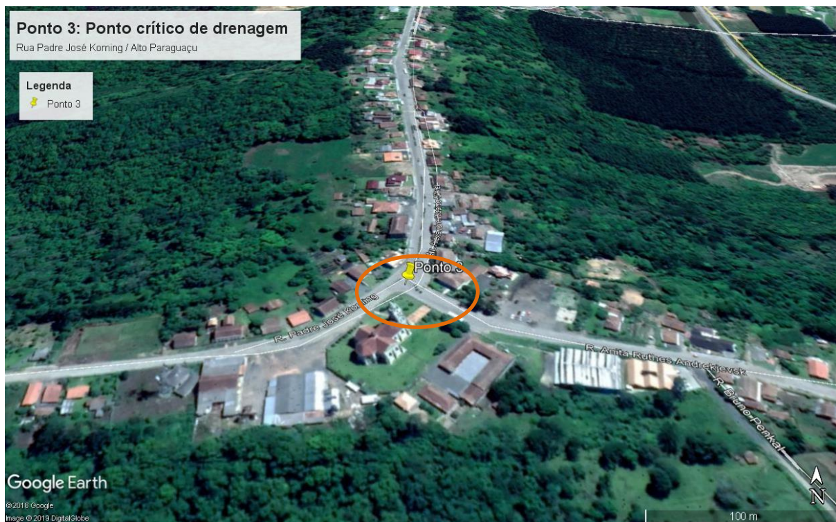
Figura 20: Ponto crítico de drenagem- deficiência no sistema - Ponto 3. Fonte: Adaptado de Google Earth.
