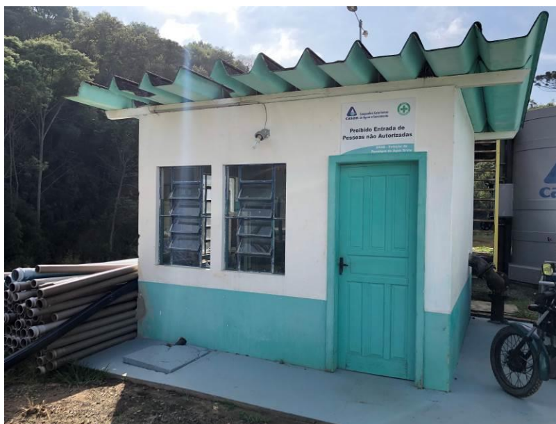
Figura 4: Estação de Recalque de Água Bruta – ERAB
