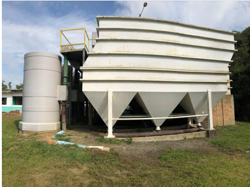
Figura 11: Vista Geral da ETA
