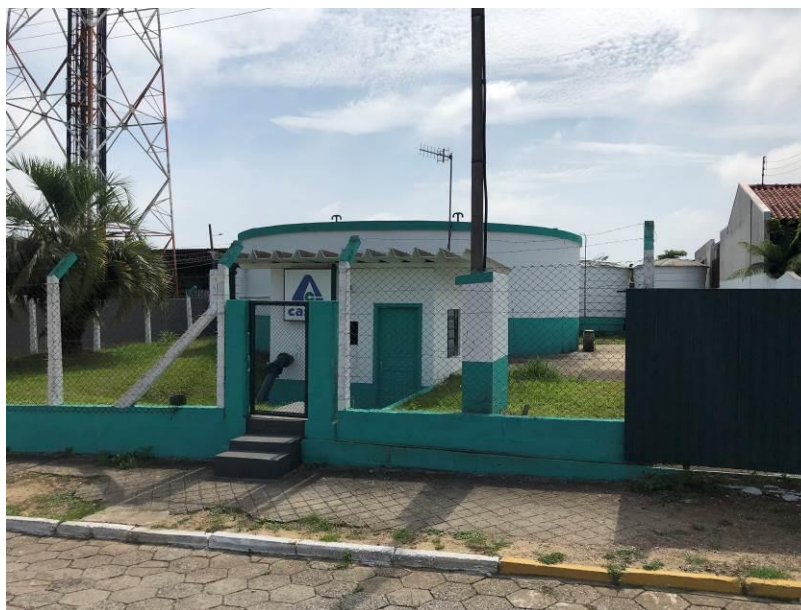
Figura 20: Reservatório Central – R1 Fonte: Arquivo técnico da consultoria, 2019.
