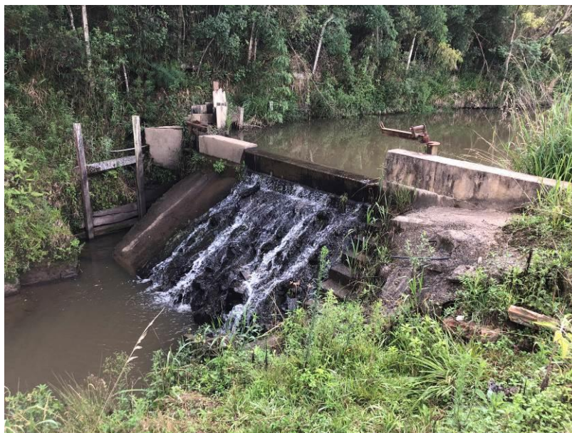
Figura 2: Vista da Captação no Rio São Lourenço
