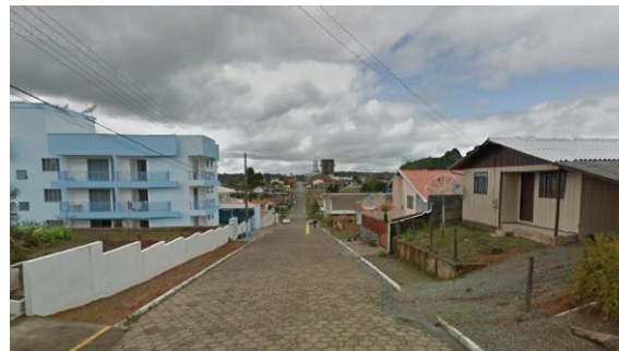
FIGURA 15: RUA RUI BARBOSA – EXEMPLO DE VIA COLETORA
