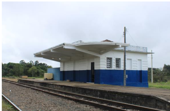
FIGURA 3: ESTAÇÃO FERROVIÁRIA ITAIÓPOLIS
