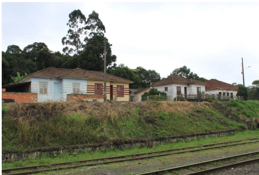
FIGURA 7: CASAS DOS FERROVIÁRIOS
