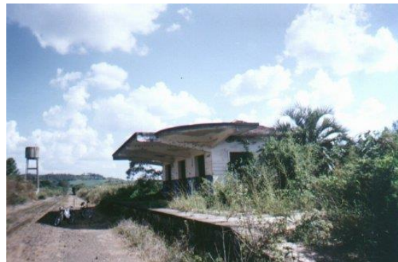
FIGURA 4: ESTAÇÃO FERROVIÁRIA CAPITÃO ADIL
