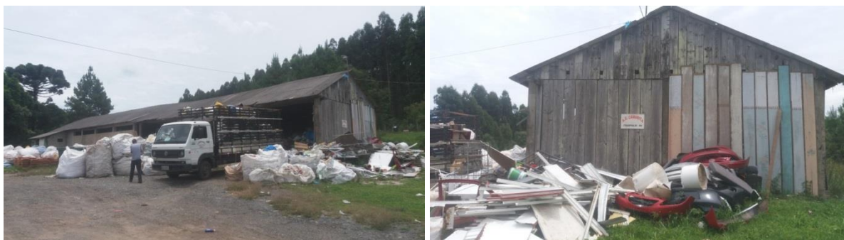
Figura 21: Vista externa do galpão de triagem. Fonte: Arquivo técnico da Consultoria, 2019.
