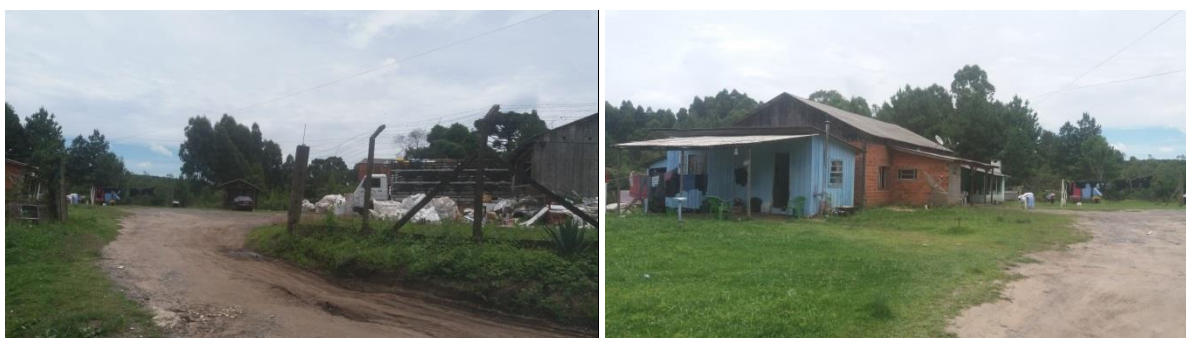
Figura 22: Vista geral do pátio da Associação e casa utilizada pelos associados, respectivamente. Fonte: Arquivo técnico da Consultoria, 2019.
