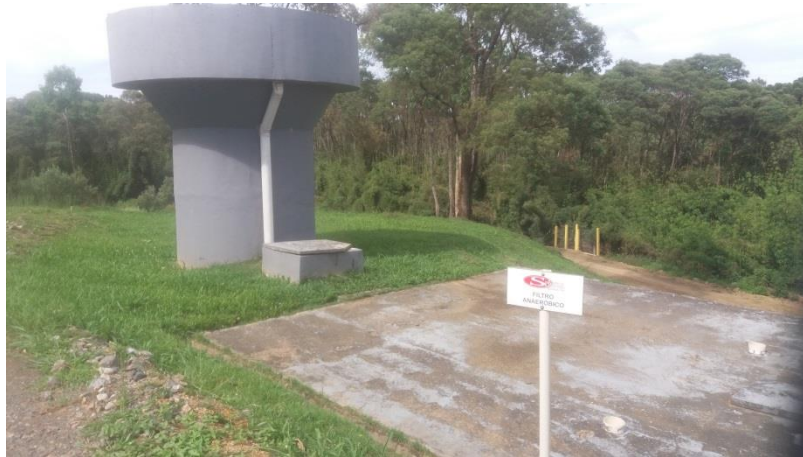
Figura 14: Reator Anaeróbio RALF. Fonte: Arquivo técnico da Consultoria, 2019.
