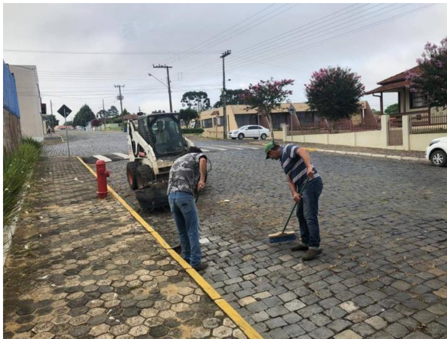
Figura 32: Roçadeira bobcat em atividade. Fonte: Sec. de Viação e Obras públicas.
