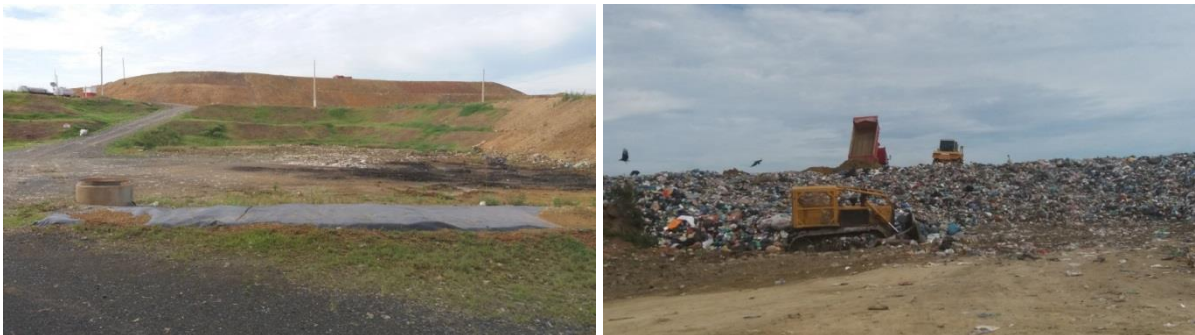
Figura 11: Resíduos Depositados na Frente de Trabalho. Fonte: Arquivo técnico da Consultoria, 2019.
