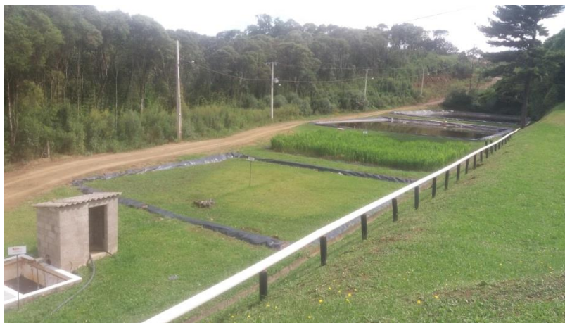
Figura 15: Lagoas e Zonas de Raízes. Fonte: Arquivo técnico da Consultoria, 2019.
