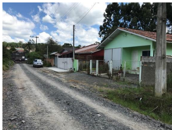
FIGURA 24: ÁREA DE RISCO NA RUA FRANCISCO DAVET – SETOR 2
