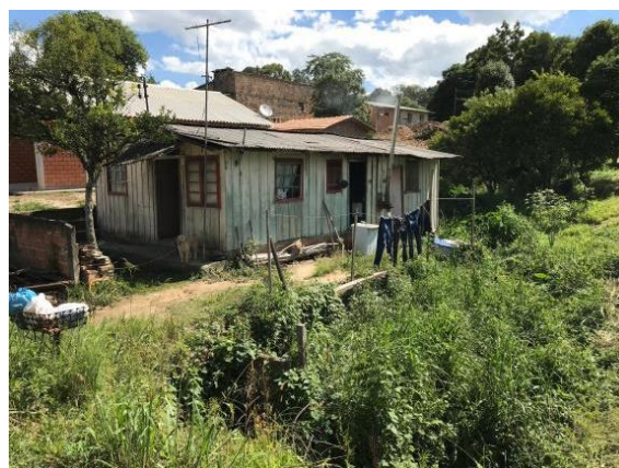
FIGURA 26: ÁREA DE RISCO NA RUA DUQUE DE CAXIAS – SETOR 4
