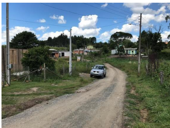
FIGURA 25: ÁREA DE RISCO NA RUA PRESIDENTE COSTA E SILVA – SETOR 3
